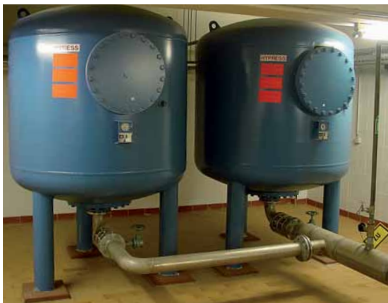
Рис. 8.1.1-с: Мембранный воздушный бак (аккумулятор)
